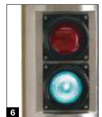
6 Zufahrtsregelung durch einseitige oder zweiseitige Ampelleuchten (rot/grün)
