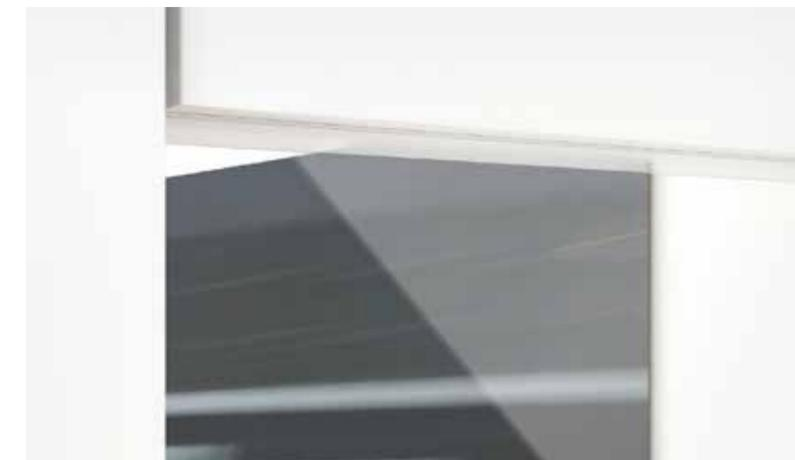
▲ Übergänge zwischen Glas und Holz durch Dichtlippe abgeschlossen
